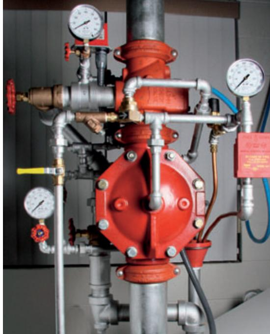
Клапан DV-5 системы предварительного действия
